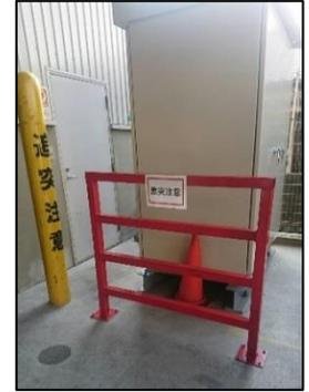
④夏の暑さ対策に本社工場2階にエアコンを取り付けるため、キュービクルを設置しました(・▽・)ナイス! またトラックやリフトの衝突防止柵をキュービクル手前に設置しました(\*≥▽≤\*)スゴイ!
