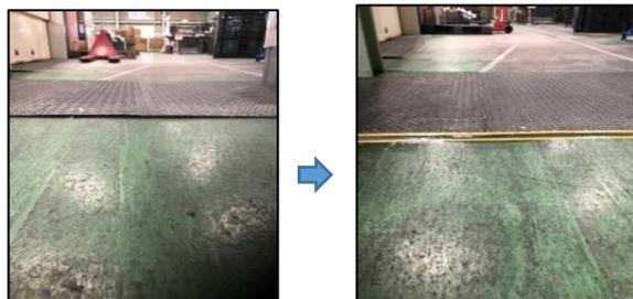
②本社2階の旋盤エリアから鋸エリアを繋ぐ鉄板と床に段差があったので、コーキング材で隙間を埋め、手押しリフトで製品を運ぶ際の荷崩れを軽減しました！by高村洋之・藤井大樹・角崎雄二・森田雅春・青松浩司
