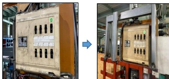
④原管移動時の接触防止に、スイッチボックスの四方をパイプで枠組みしました。by柳 和宏
