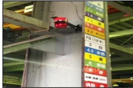
②2階への材料上げ下げ時にセンサーが感知して、注意喚起のパトライトが回るようにしました。
